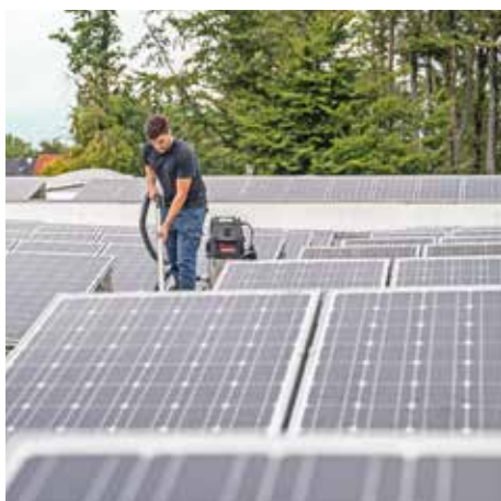
R18 D Čištění mezi fotovoltaickými prvky
