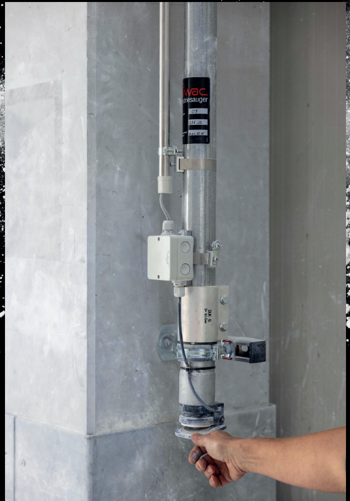
02 Einfacher mit zentraler Absaugung: Nur den Schlauch in den Saugstutzen stecken, und ab geht die Reinigung
